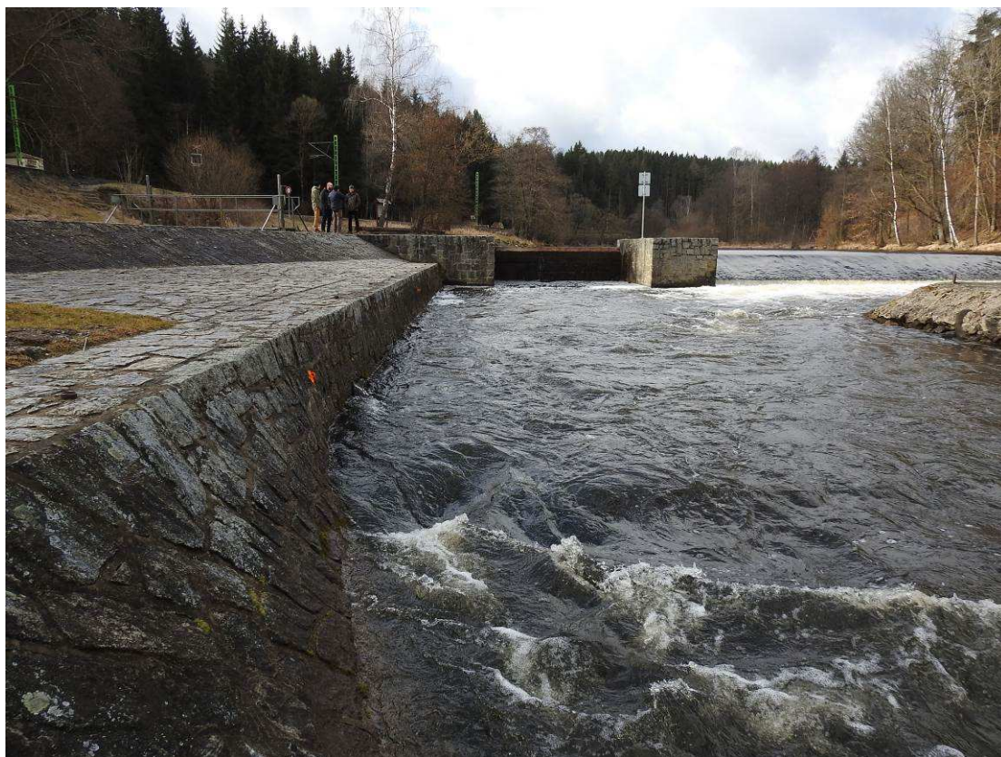
Obr.6. Pohled na podjezď pod vorovou propustí a opevnění pravého břehu v podjezď
