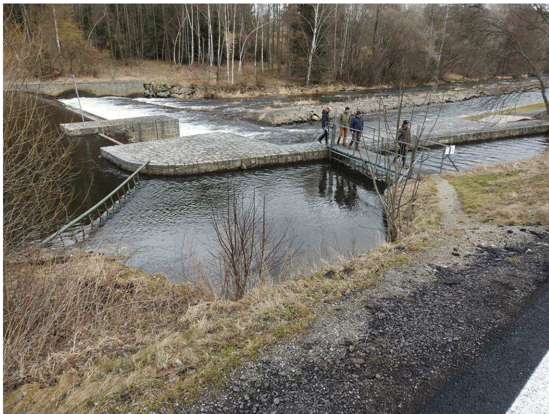
Obr.1. Celkový pohled na jezové těleso s odbočením náhonu z pravého břehu
